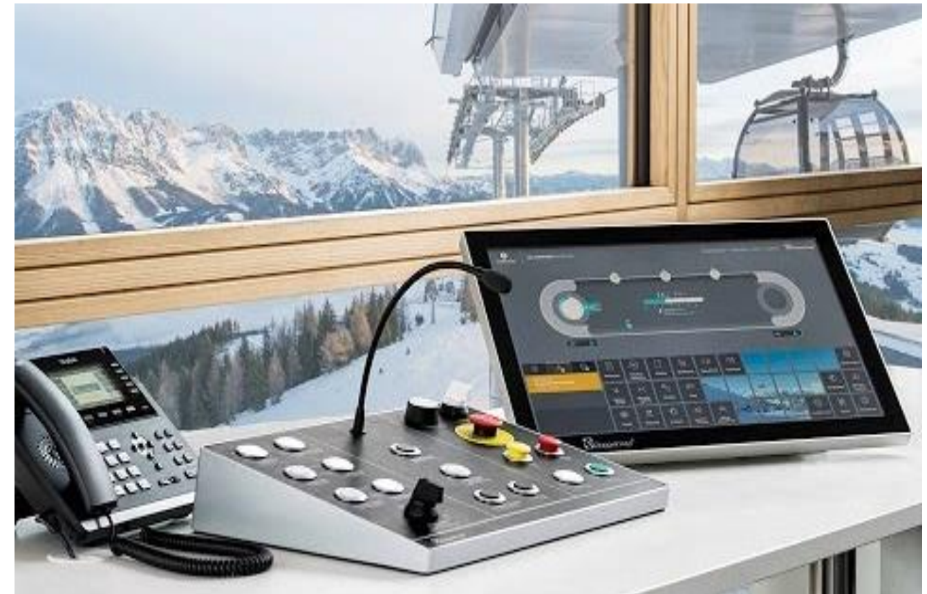
Fig. 33 Sala de control
