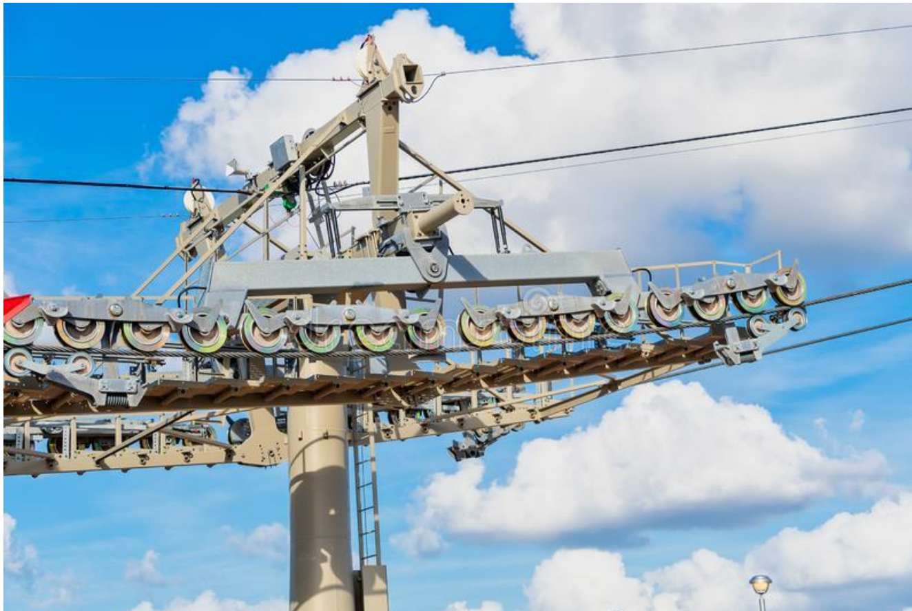
Fig. 27 Tren de poleas de línea
